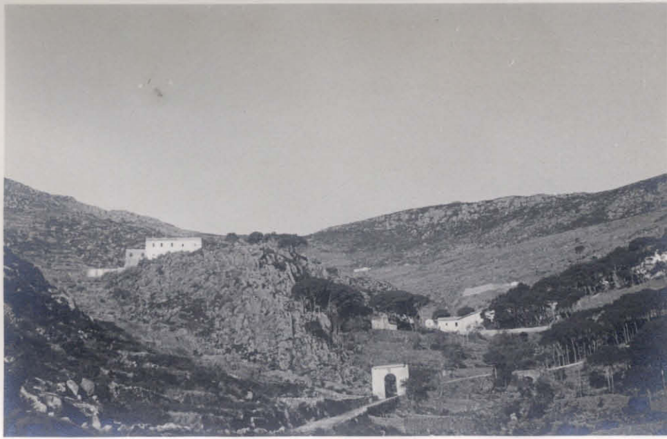
Un arco sulla via segna l'in- gresso della Colonia.
